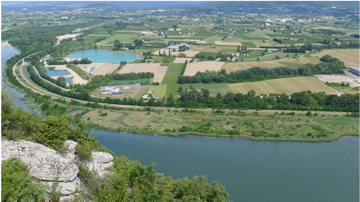
Figure 9 : Grande roselière en mai 2011 (avant les travaux de rajeunissement de février 2012)
